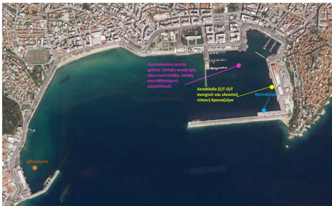
Σχήμα 3-10. Δραστηριότητες του λιμένα Καβάλας (Πηγή: Google Earth)
